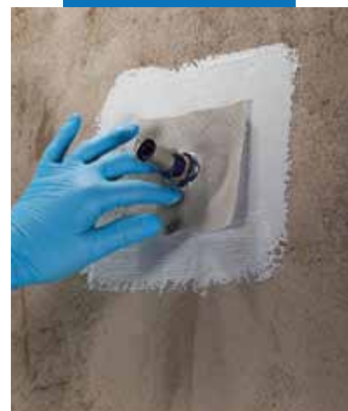
Нанесение Mapeband PE 120 для герметизации проходных отверстий, используя Mapegum WPS
