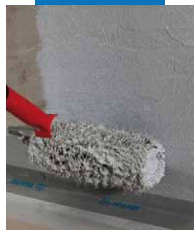
Нанесение Mapegum WPS с помощью валика
