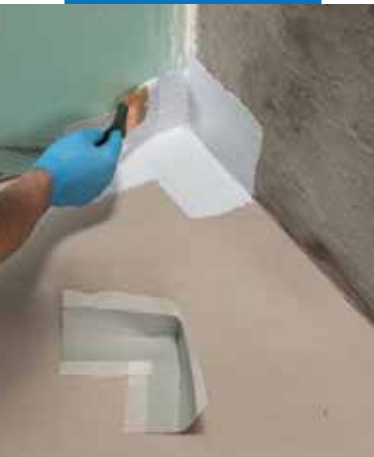
Нанесение на угол 90° углового Mareband PE 120, используя Maregam WPS
