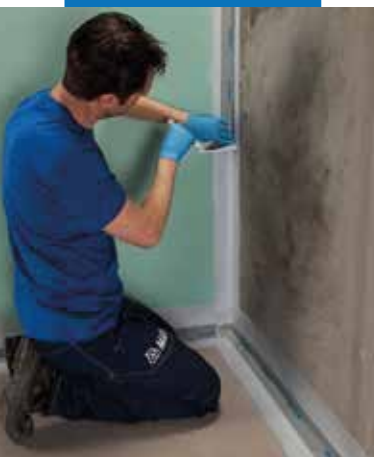
Нанесение Mareband PE 120 используя Maregam WPS
