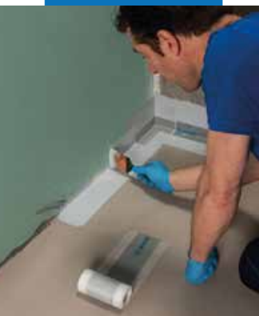
Нанесение Mareband PE 120, используя Maregam WPS
