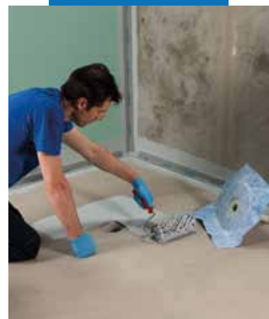
Установка Drain Vertical , используя Mapegum WPS
